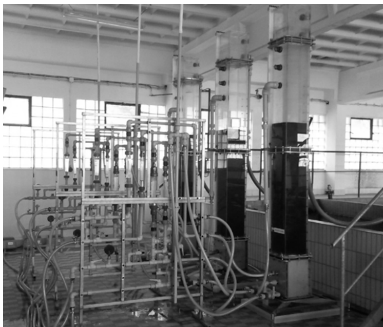
Obr. 2. ÚV Písek – umístění poloprovozních modelů filtrace v prostoru sedimentačních nádrží
